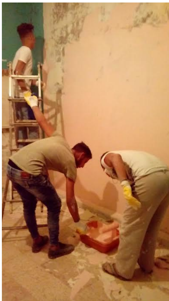
Travaux de peinture par de jeunes volontaires
