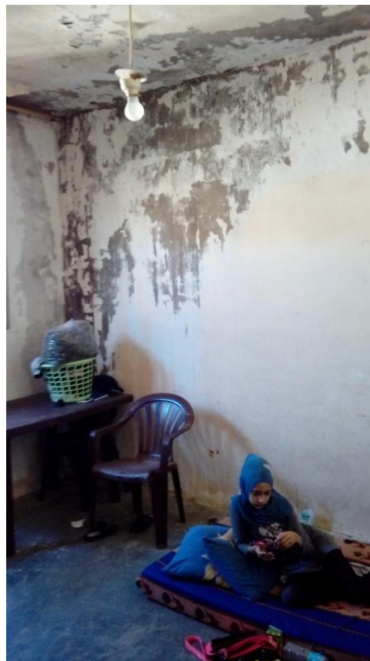
Un logement avant travaux
