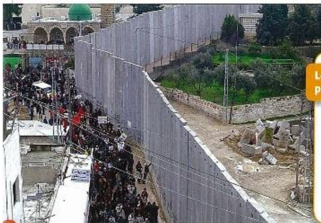
2 Le mur au niveau de Jérusalem
