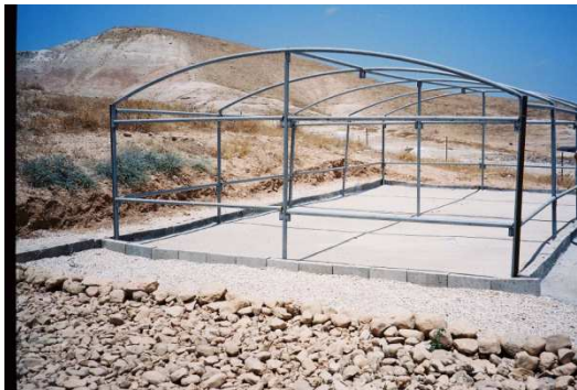
une dalle bétonnée + une structure en arceaux de 60m2
