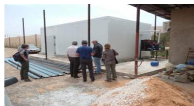
Construction de la chambre froide d'Al Jiftlik
