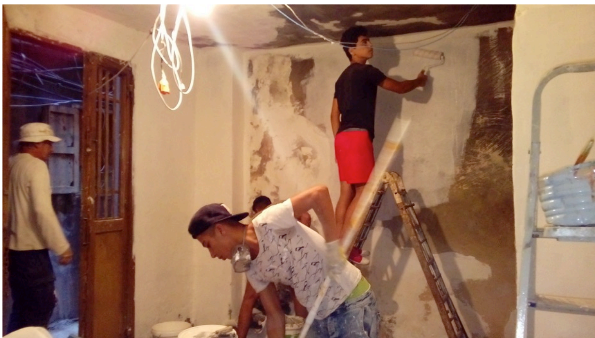
Travaux de peinture dans un logement
