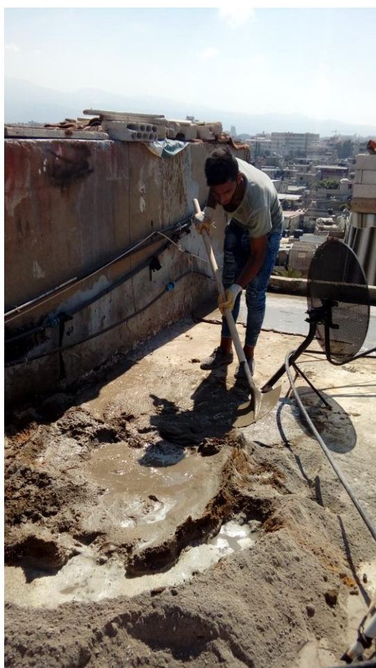
Préparation du béton sur la terrasse
