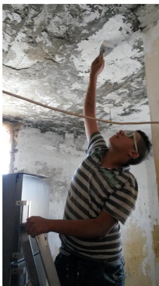
Travaux sur le plafond du logement
