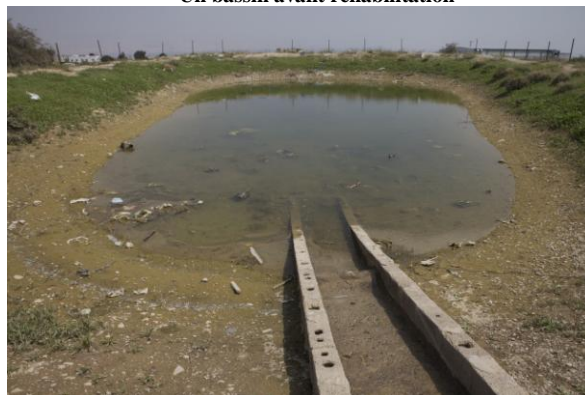
Un bassin avant réhabilitation
