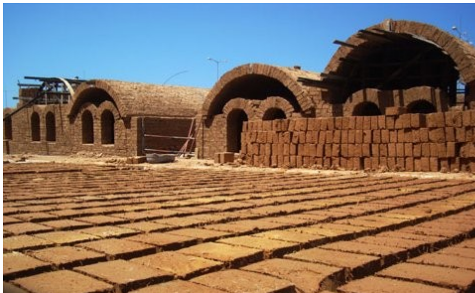
Le nouveau poste de police en construction avec de la boue
