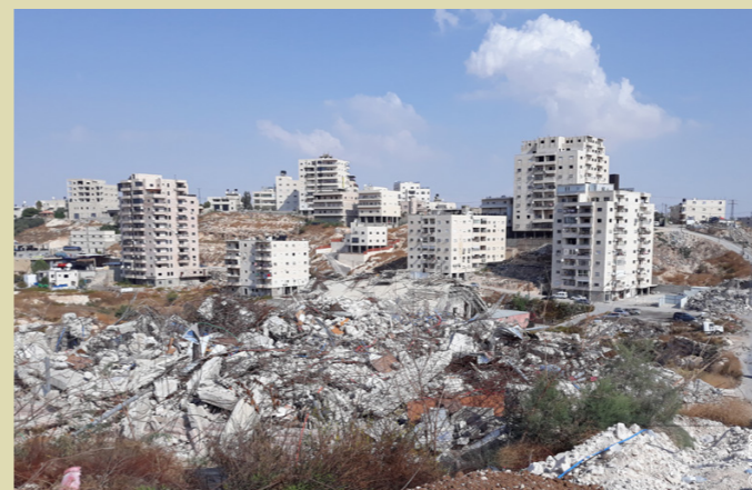
Surbahir, situé en zone A, immeuble dynamité car jugé trop proche du mur en vertu d'un règlement israélien
