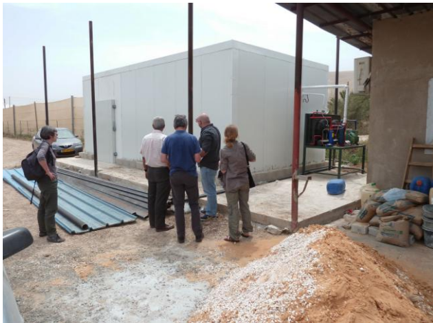
Vue globale de la chambre froide installée
